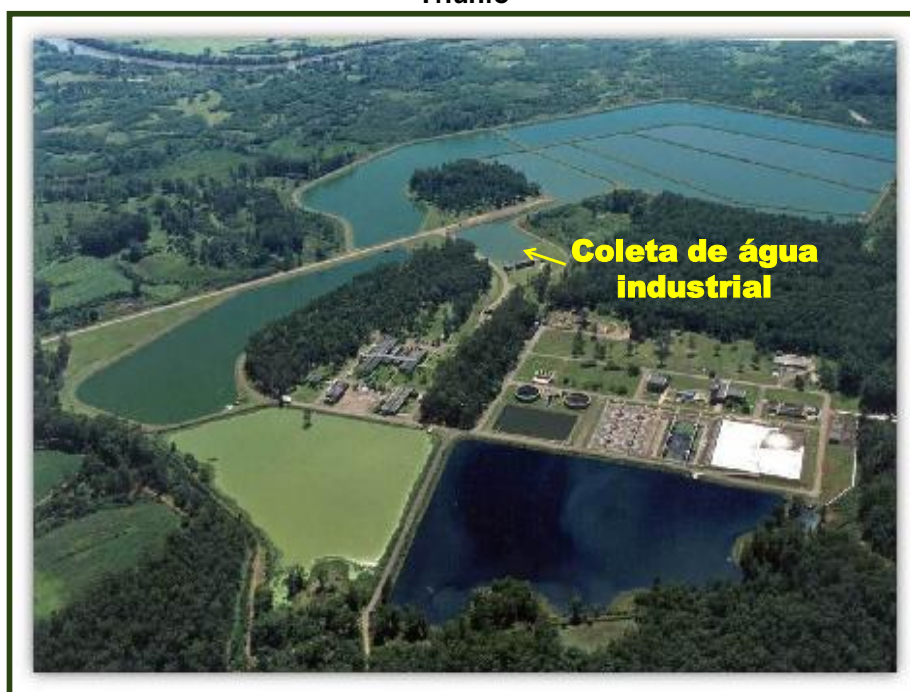
Figura 13 - Vista aérea do tratamento de efluentes convencional do Polo Petroquímico de Triunfo
