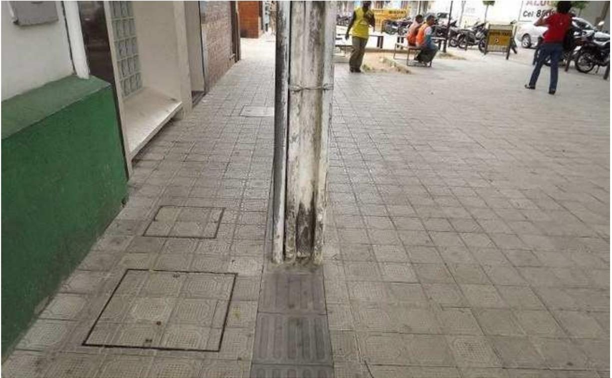
**Figura 28: Poste colocado sobre piso tátil em calçada**
