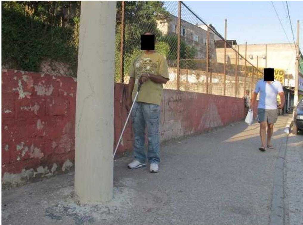
**Figura 27: Poste colocado em posição incorreta na calçada**
