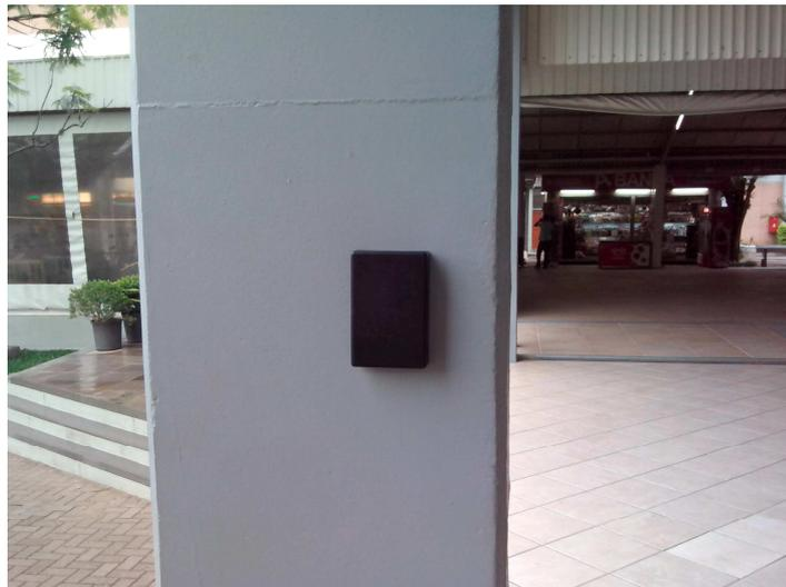
**Figura 22: Caixa plástica com os equipamentos de transmissão fixada por fita adesiva na co-**
