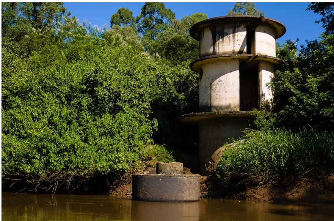
Figura 61 - Fotografia de Guto Maahs, registrada em 03/03/2010 – Antiga captação de água bruta do Serviço de Água e Esgotos – SEMAE, no Rio dos Sinos em São Leopoldo/RS.
