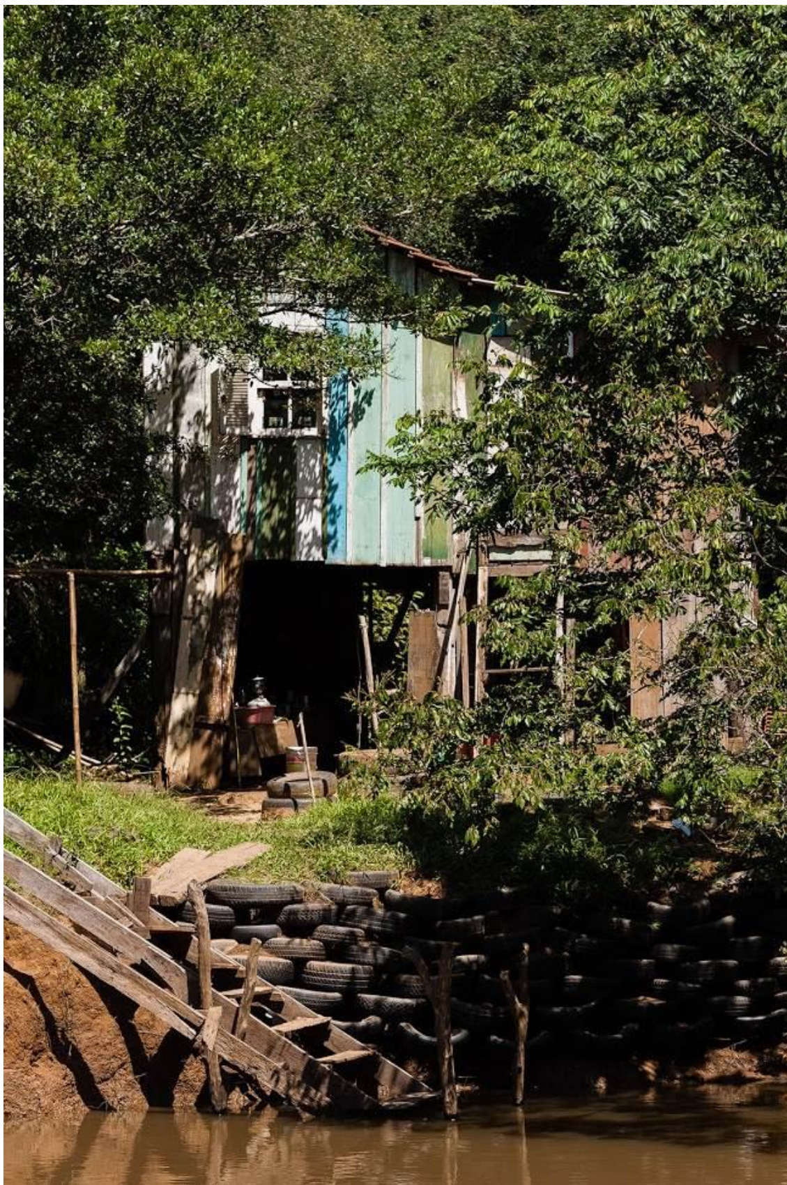
Figura 43 - Fotografia de Guto Maahs, registrada em 18/03/2010 – Moradia sobre palafitas à margem do Rio dos Sinos entre Sapucaia do Sul e Canoas/RS.
