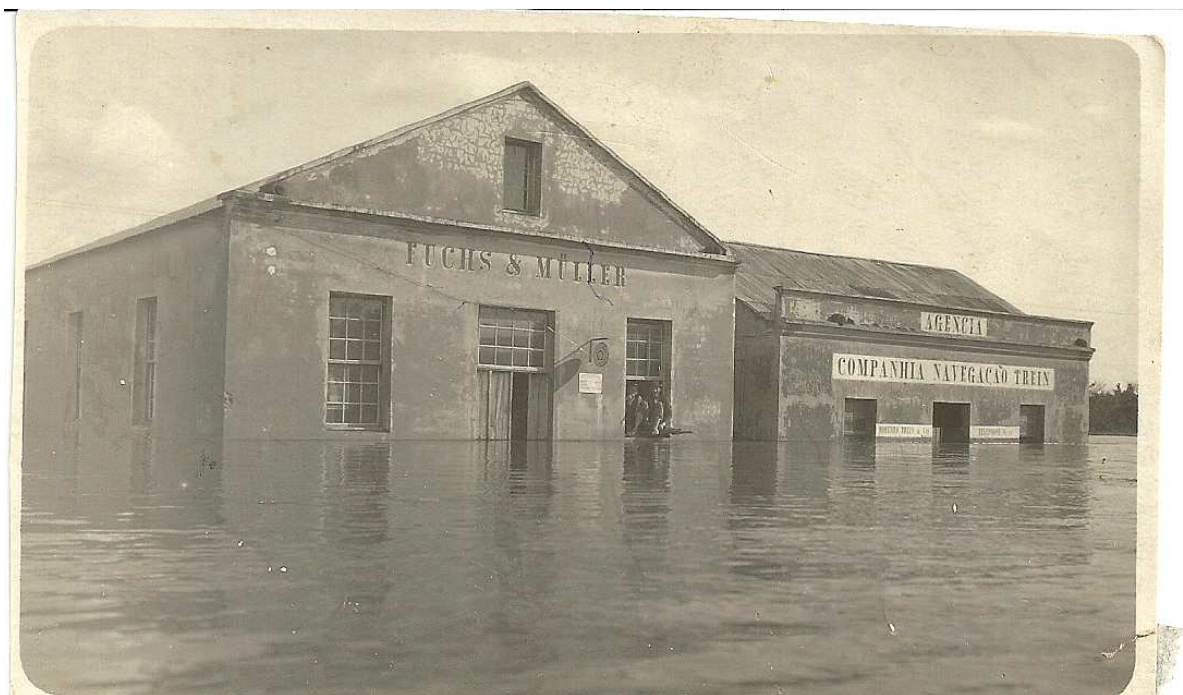
Figura 15 – Prédios inundados pela cheia de 1928.
