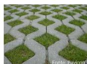
Pavigrama (blocos vazados de concreto com grama) na área do estacionamento para auxiliar na permeabilidade do lote e trazer mais verde para a parte do lote próxima a Av. 25 de Julho.
