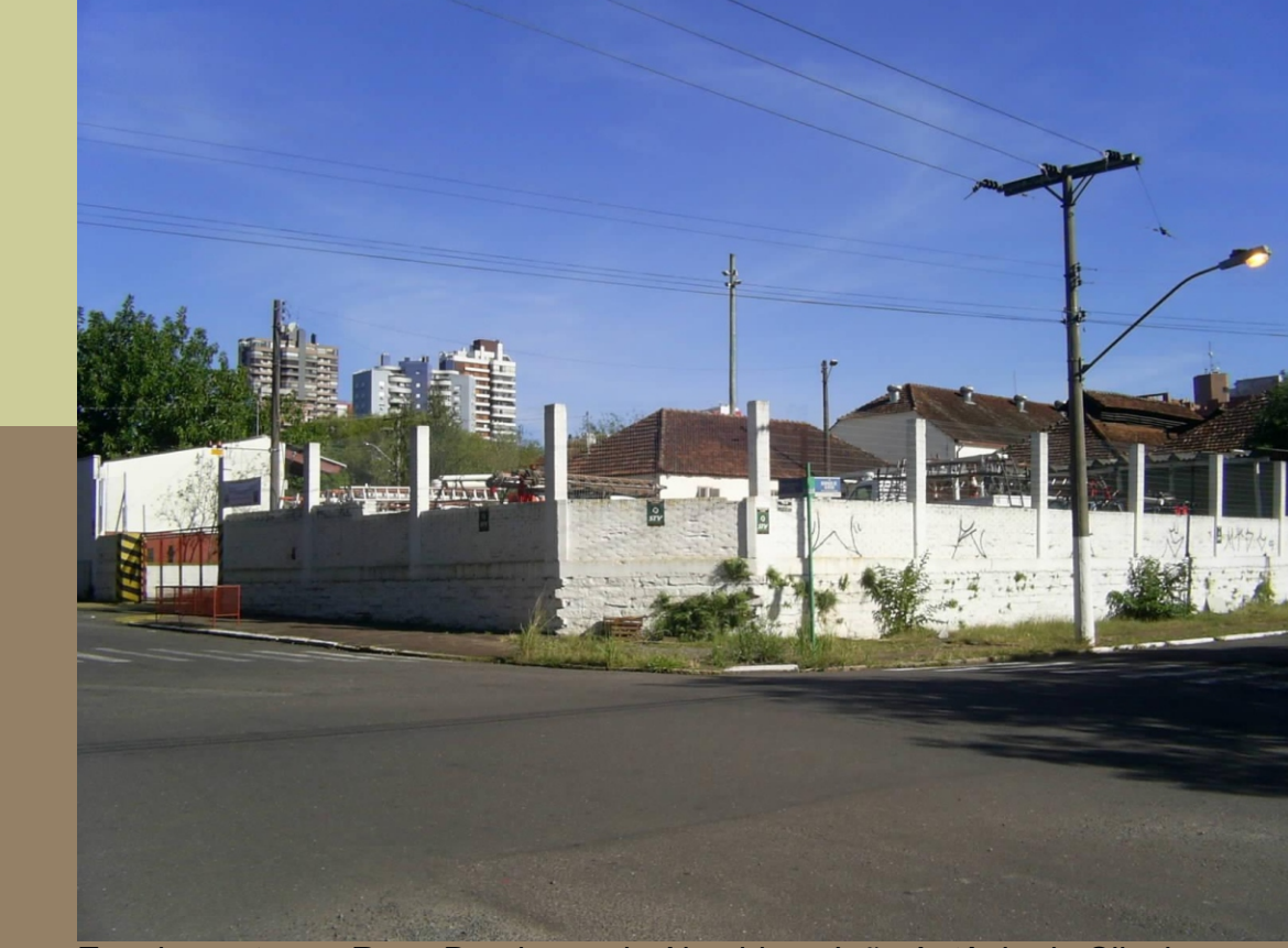
Esquina entre as Ruas Domingos de Almeida e João Antônio da Silveira
