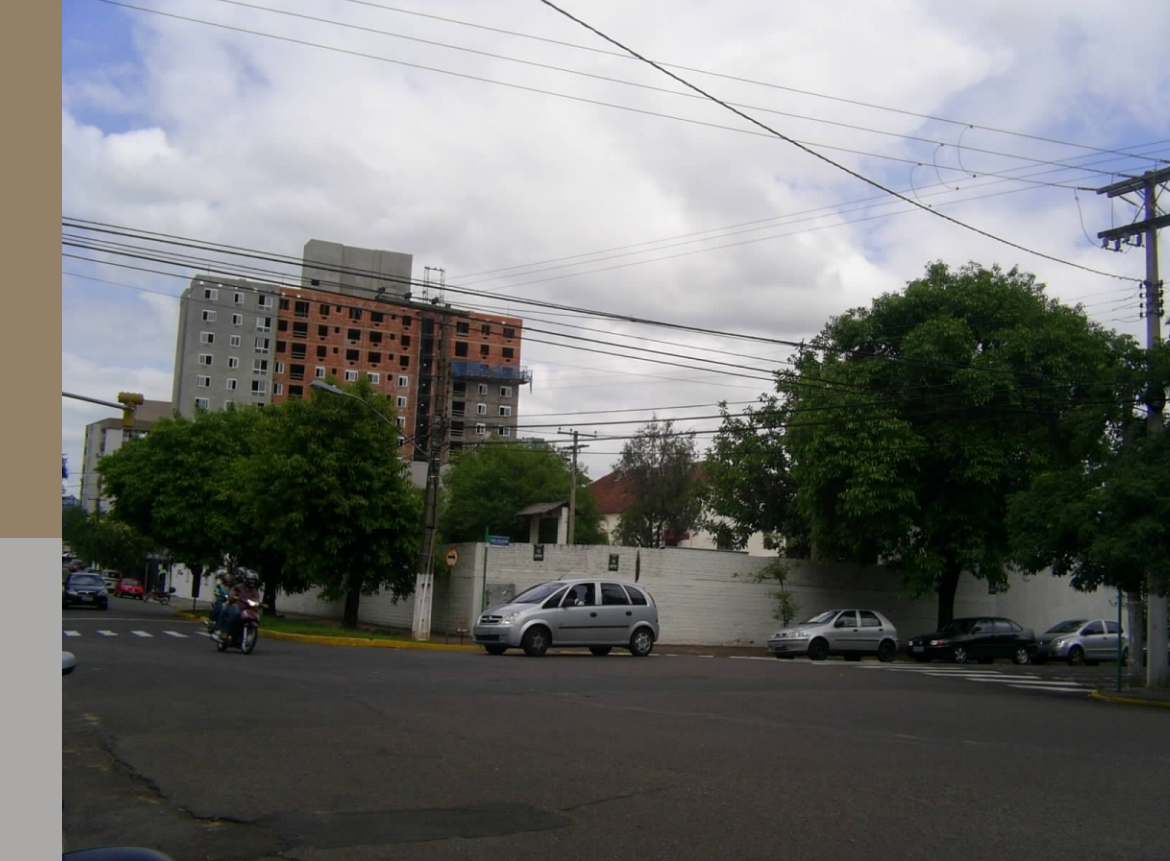
Esquina entre as Ruas João Antônio da Silveira e Júlio de Castilhos DEZEMBRO DE 2009, com o Ed. Down Town em construção ao fundo da imagem
