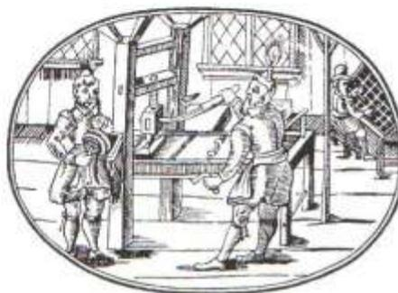
**Figura 03 - A oficina gráfica do século XVII: ao lado do impressor, que maneja a prensa de madeira com torculo, o entintador, e ao fundo, o compositor, com a caixa de tipos.**
