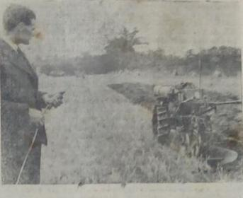
Este pequeno tractor controlado pelo radio foi recentemente experimentado com inteiro êxito numa fazenda da Inglaterra... O tractor pode abrir perfetos sulcos no solo e fazer toda espécie de voltas, por meio de controle à distancia. Um só operador, sentado no interior de uma cabine para ficar ao abrigo do sol ou da chuva, pode controlar dez tratores de uma só vez, colocados um atrás do outro.
