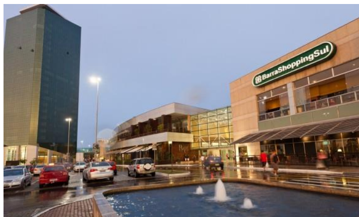
Figura 4 - Fachada Barra Shopping Sul
