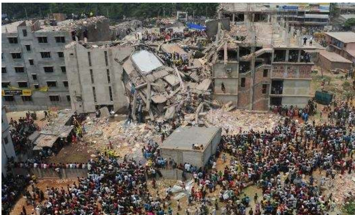
Figura 24 - Prédio Rana Plaza em Bangladesh Após o Desabamento
