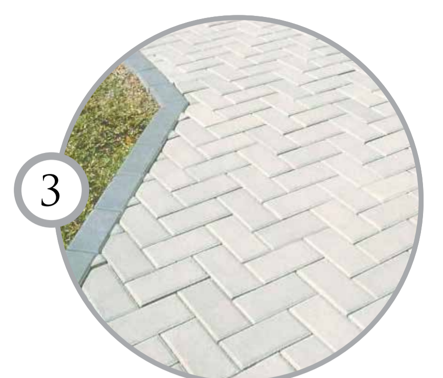
3 BLOQUETOS DE CONCRETO INTERTRAVADOS 220X110MM
