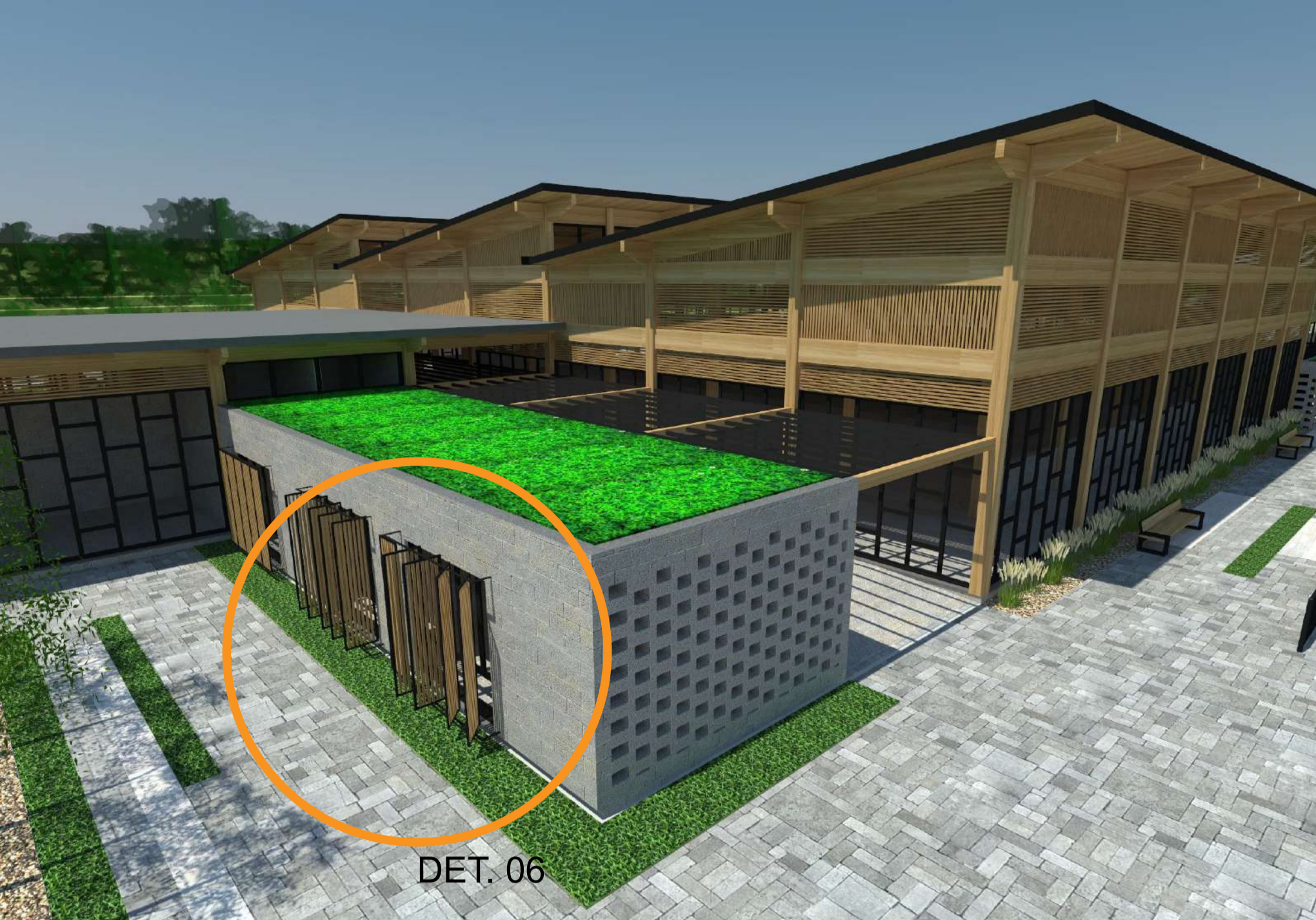
PILARES DE MADEIRA LAMINADA COLADA E ALVENARIA PORTANTE
