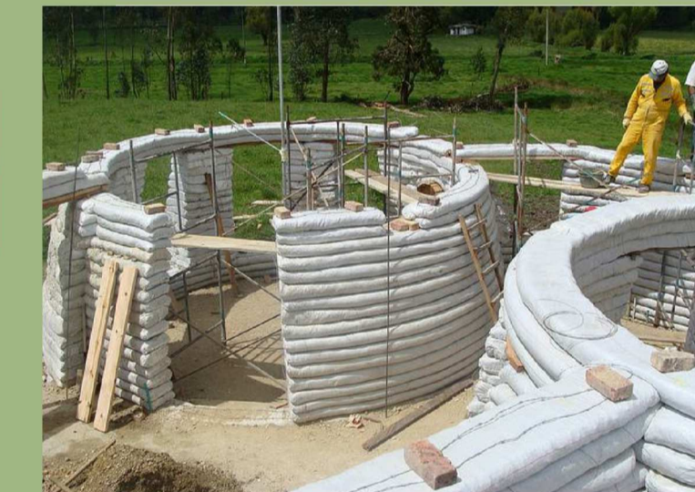
EXEMPLO DE CONSTRUÇÃO EM SUPERADOBES
