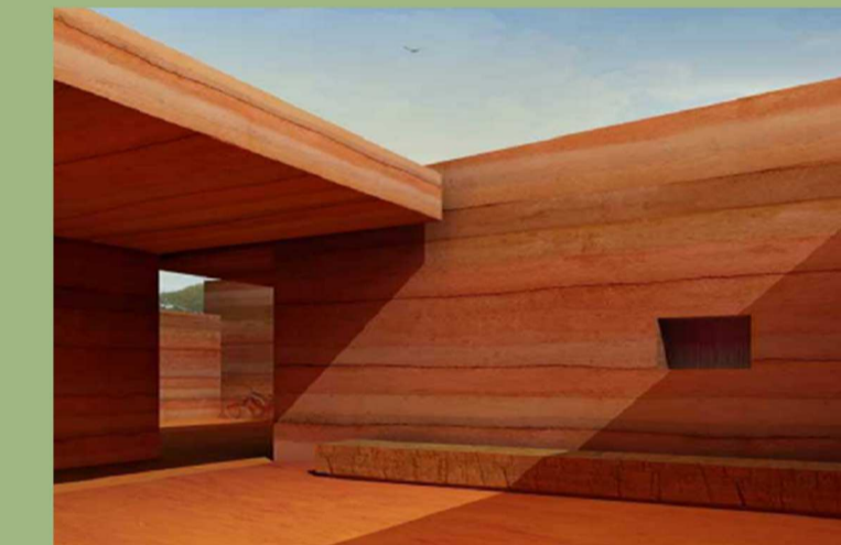
EXEMPLO DE CONSTRUÇÃO EM TAIPA-DE-PILÃO
