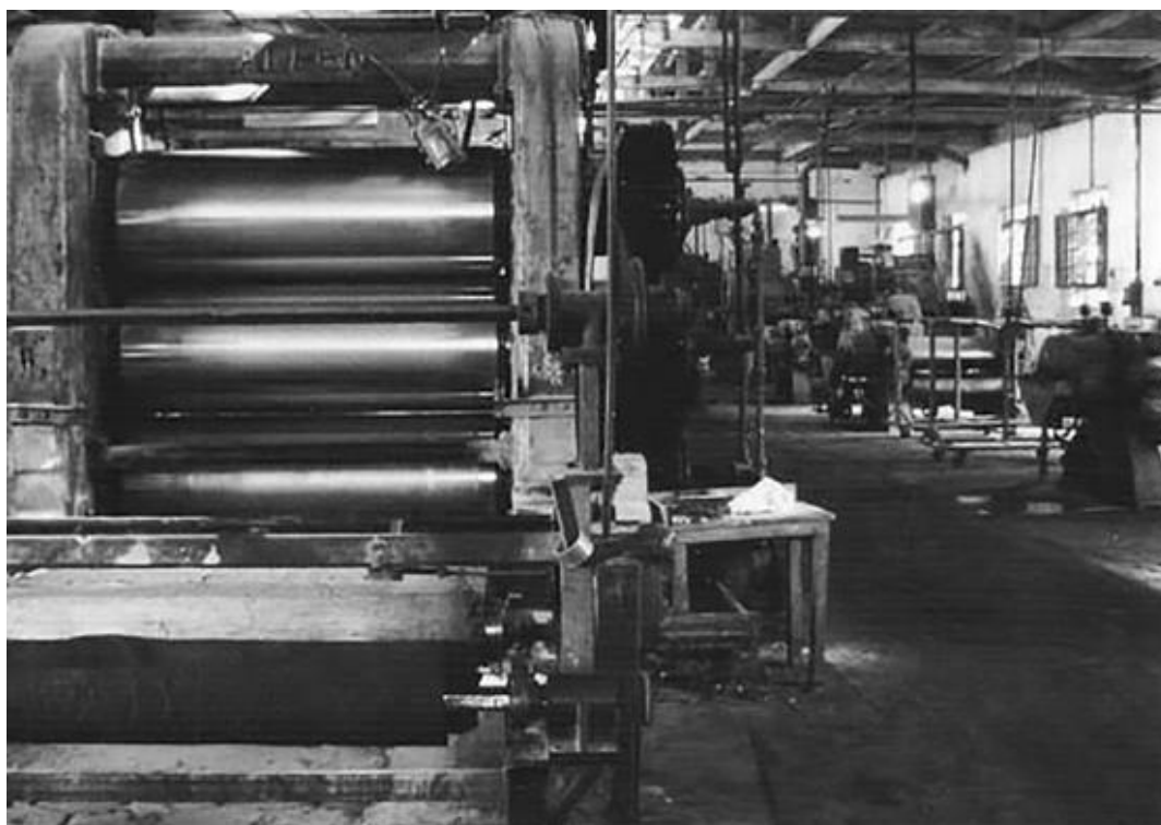
Figura 22 – Foto do maquinário da empresa Borbonite
