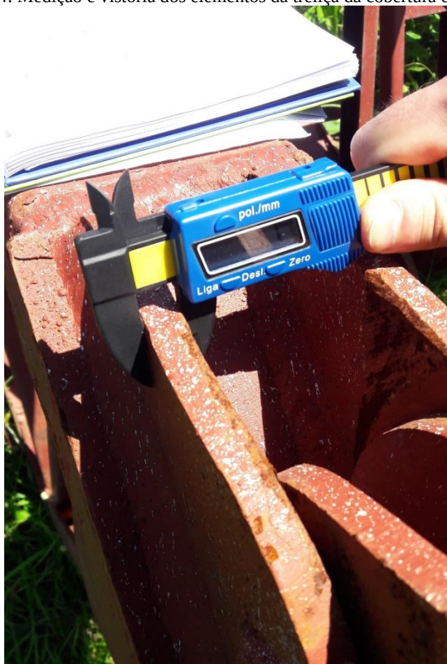
Figura 24: Medição e vistoria dos elementos da treliça da cobertura em estudo.
