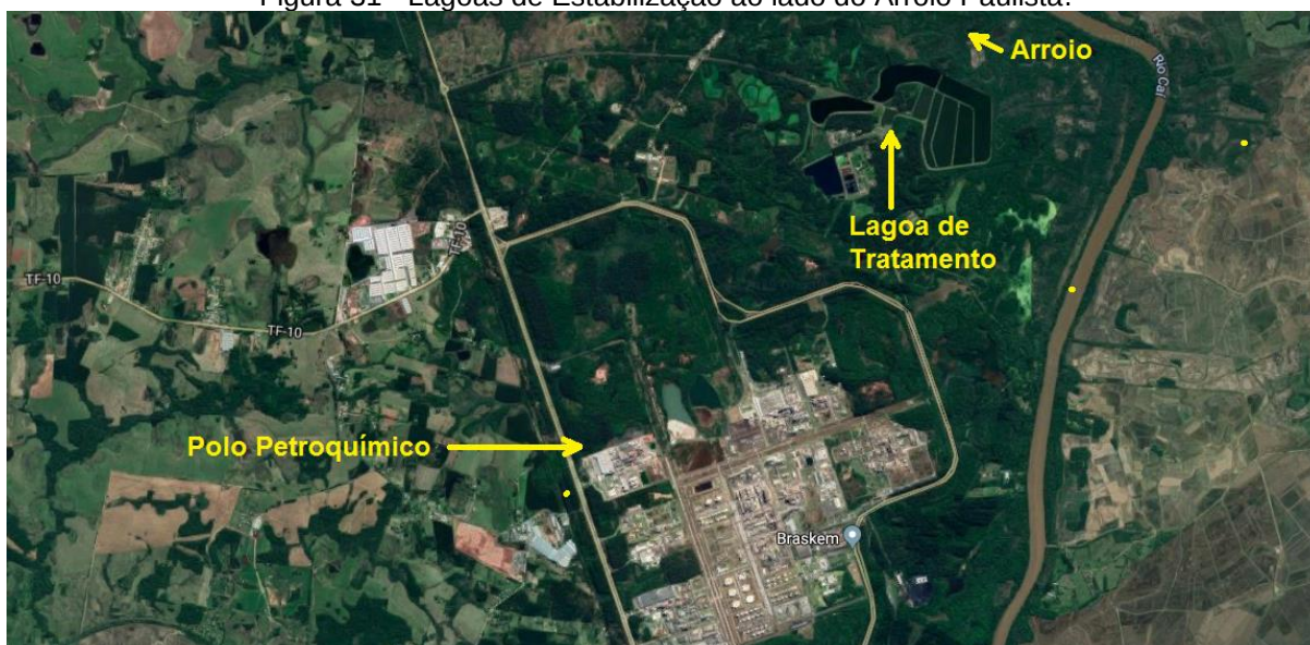
Figura 31 - Lagoas de Estabilização ao lado do Arroio Paulista.
