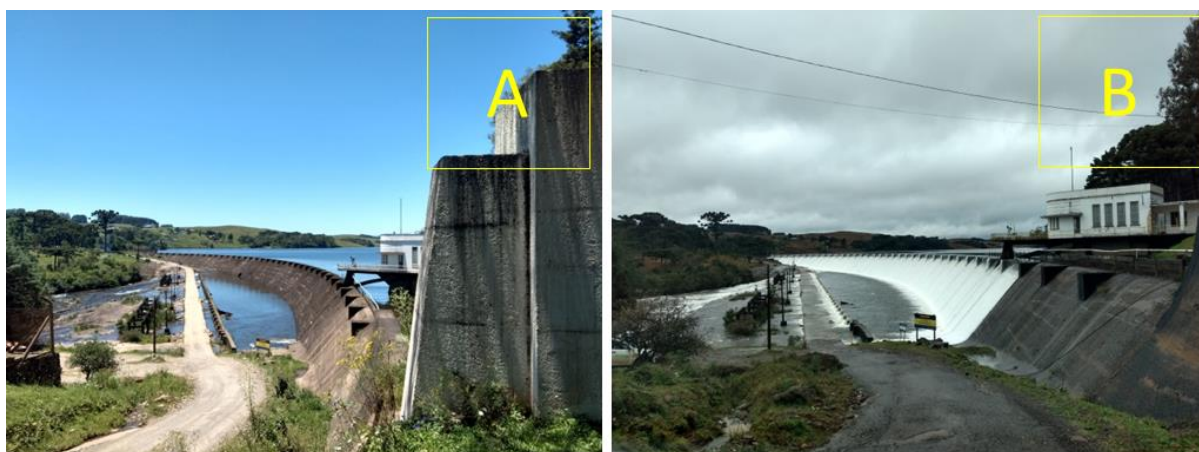
Figura 13 - Barragem do Salto: A – baixa vazão, B – alta vazão.
