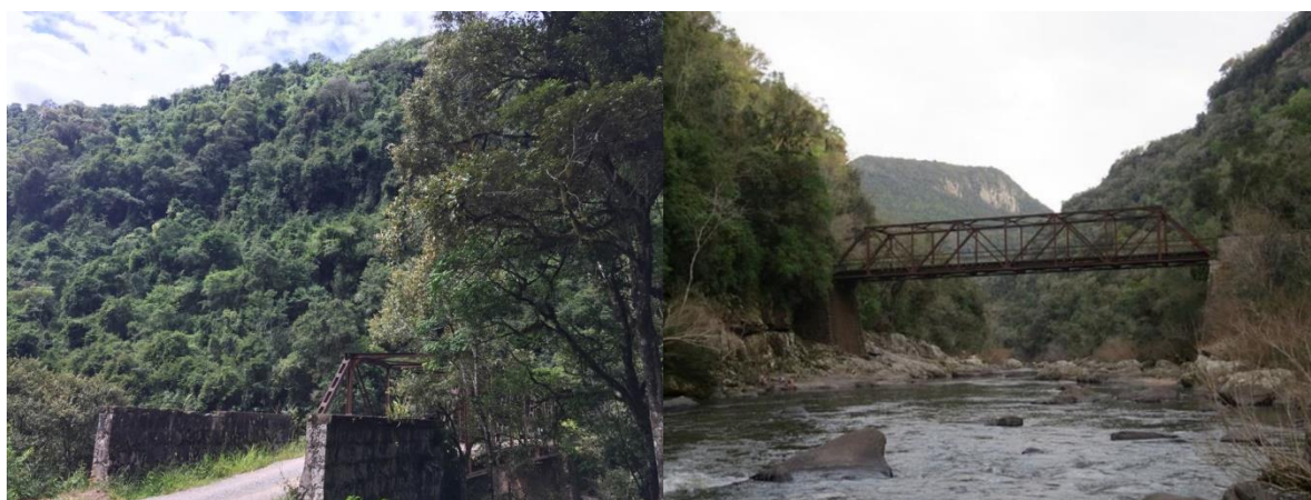
Figura 17 - Ponte do Raposo
