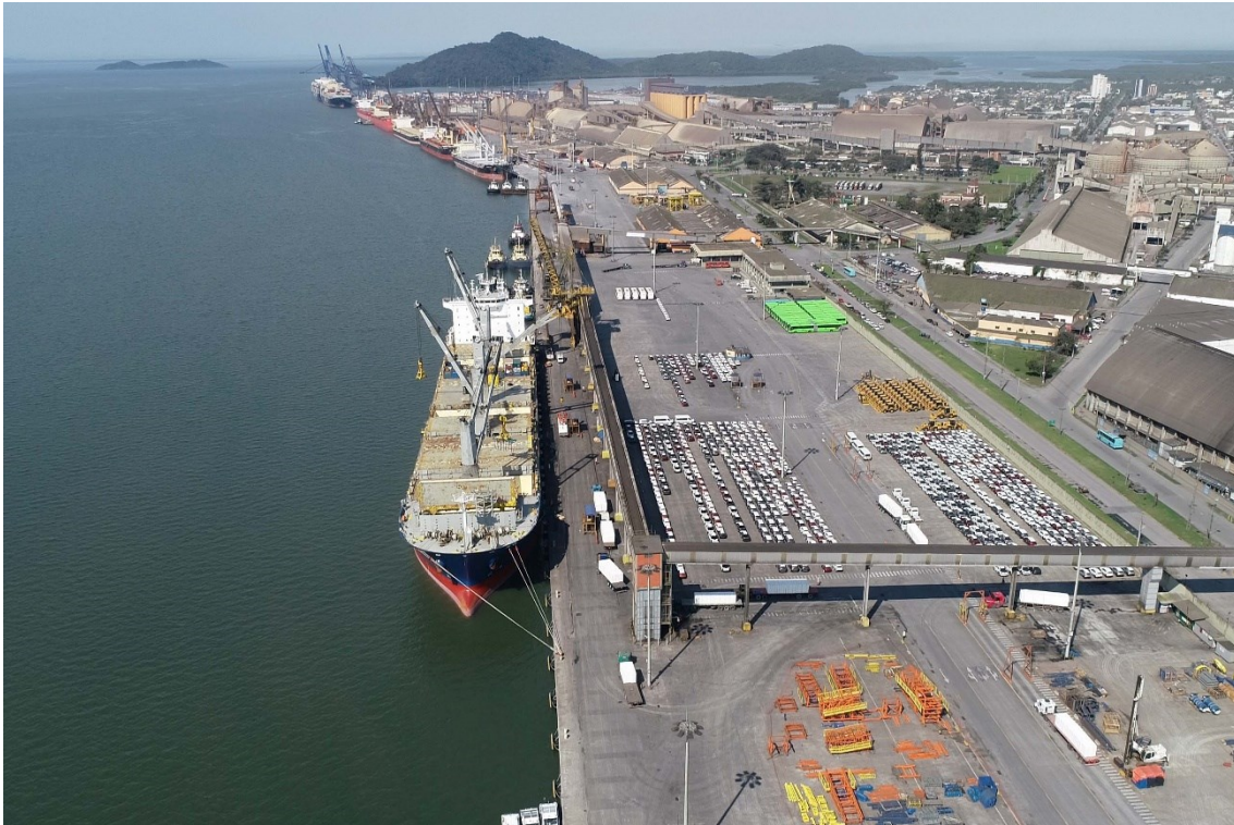
Figura 10 - Porto de Paranaguá
