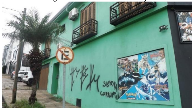
Figura 18 - Fachada lateral da loja
