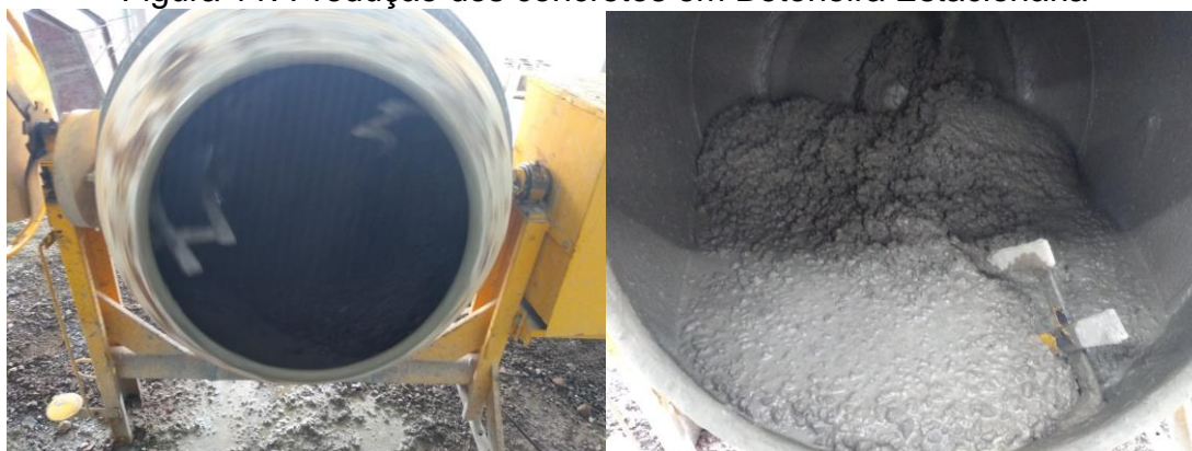
Figura 11: Produção dos concretos em Betoneira Estacionária
