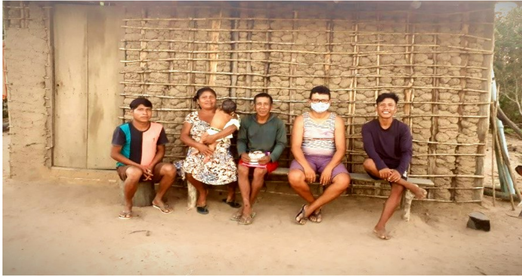
Imagem 2 - Frente de casa tampada com esteios e varas à mostra (Aldeia Geremias)
