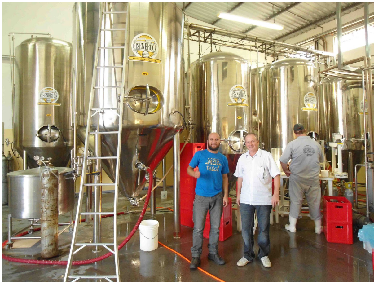
Figura 19 - Tanques de armazenamento da cervejaria Altenbrück
