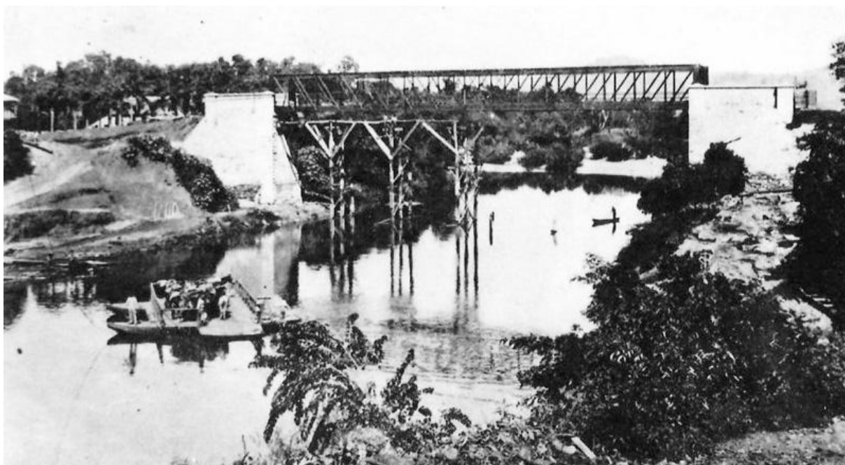
Figura 11 - A balsa e a ponte de ferro
