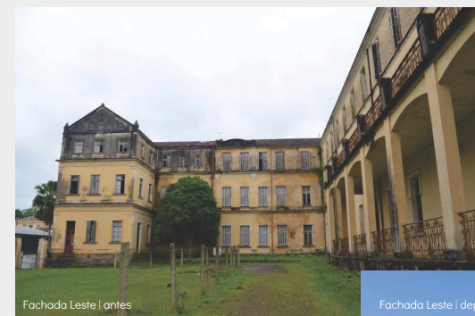
Fachada Leste | antes
