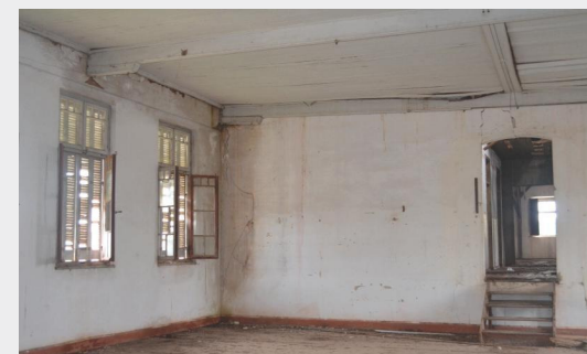
Salão Terceiro Pavimento | antes
