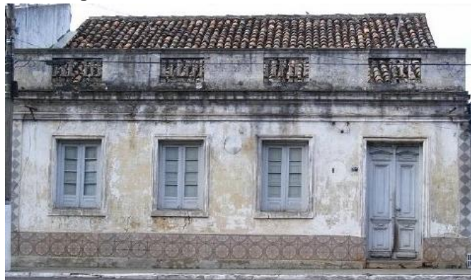
Figura 5 - Casa de Bento Manoel Ribeiro
