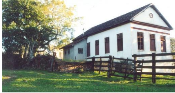
Figura 31 - Ruínas do Hospital Farroupilha
